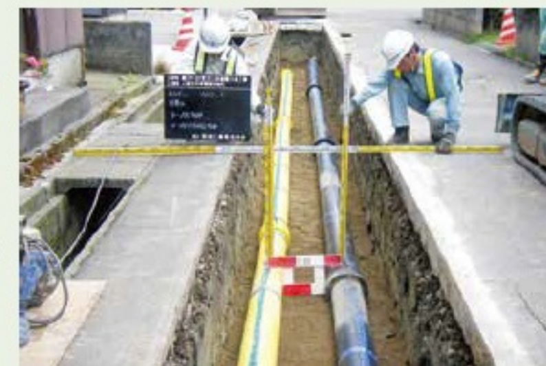
耐震性に優れた管への入替
