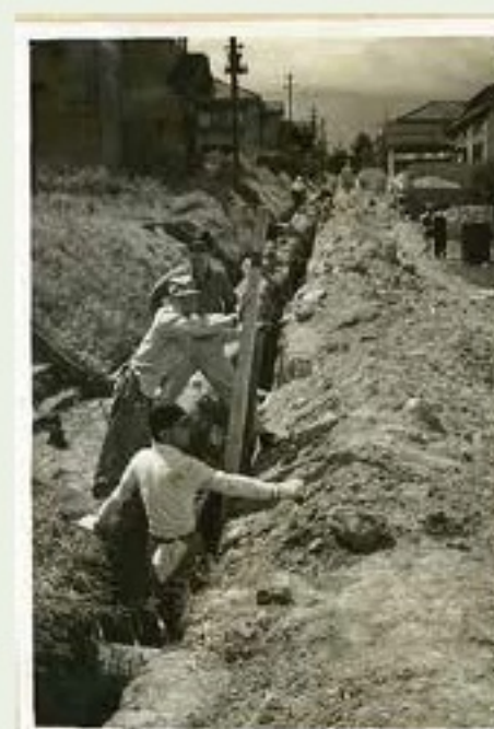
昭和38年頃の中郷村の 配管工事の様子
