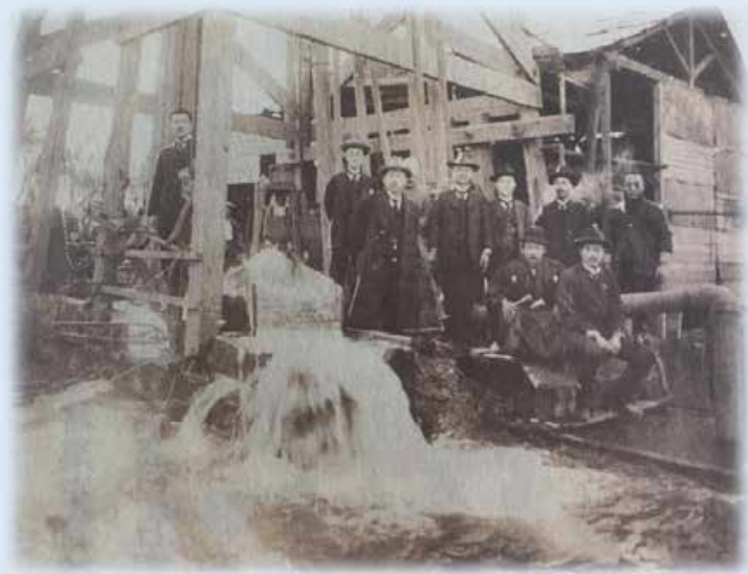
▲第一水源地（現在の南城町4丁目）の工事の様子 大正末期
