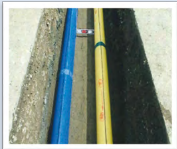
右側（黄色） ガス用ポリエチレン管 左側（青色） 水道用ポリエチレン管
