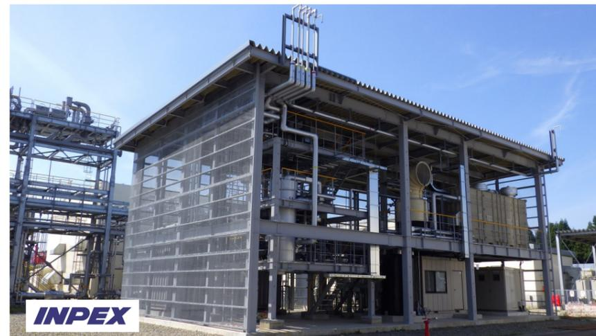
上越市ガス水道局のガス卸元である株式会社INPEXでは、電気から水素、水素からメタン、メタンから電気へ変換する各技術と、メタンの生産から輸送までの既存のシステムを組み込んだ「電気-水素-メタンのバリューチェーン」の形成を目指し、核となる技術としてメタネーション技術の開発に取り組んでいます。
