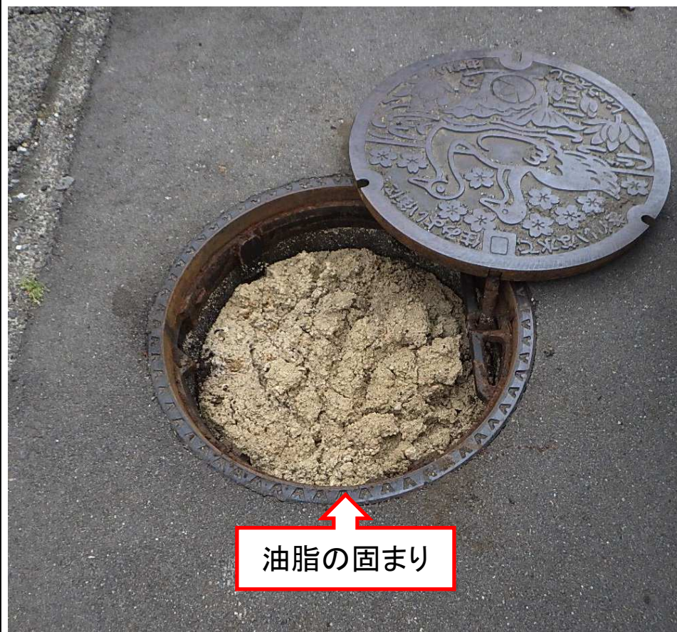
③ マンホールの状況
