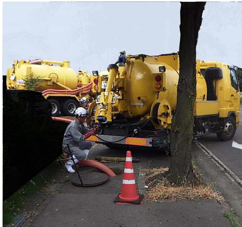
④ 復旧作業の様子
