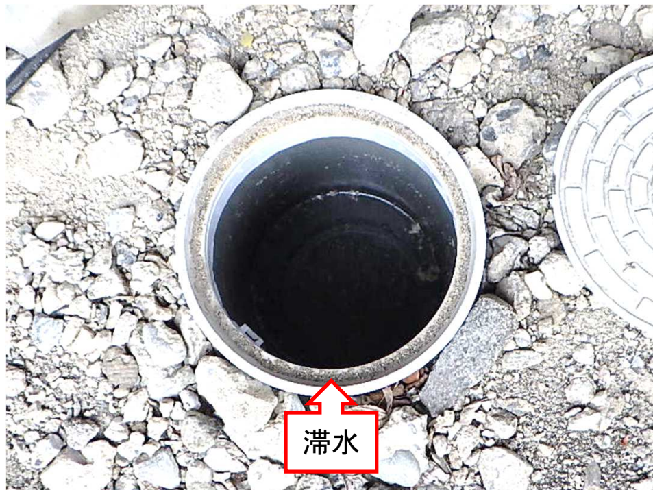
① 汚水ますの状況
