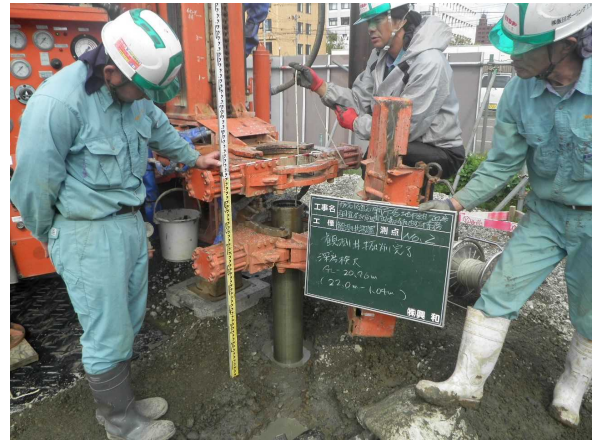
掘削深度測定
