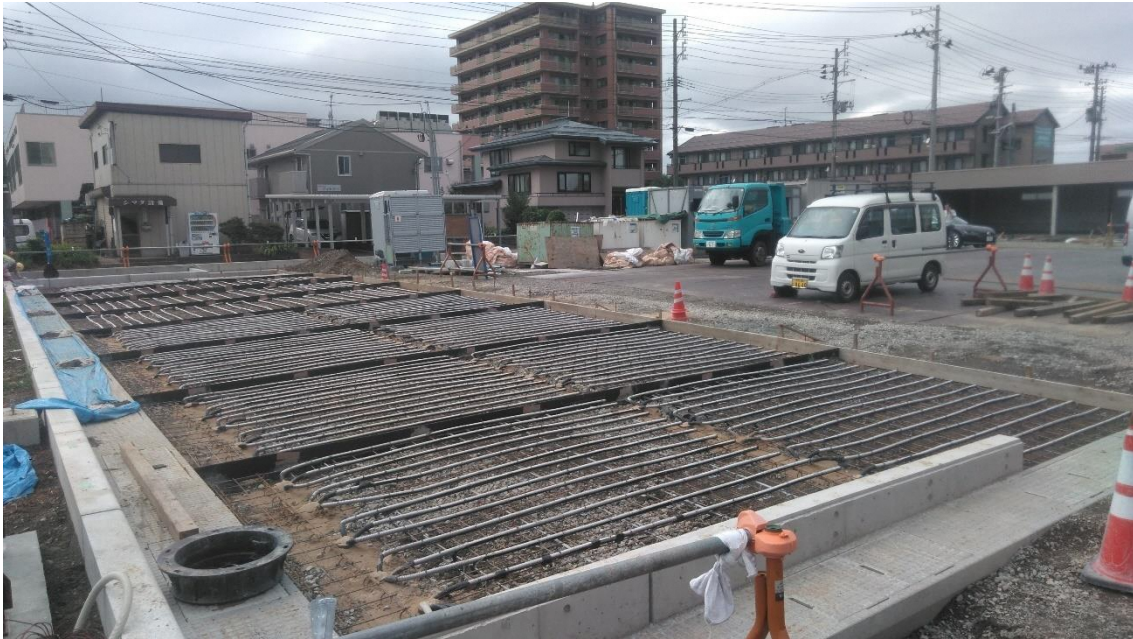
写真 3-1 ヒートパイプ敷設状況(西面)
