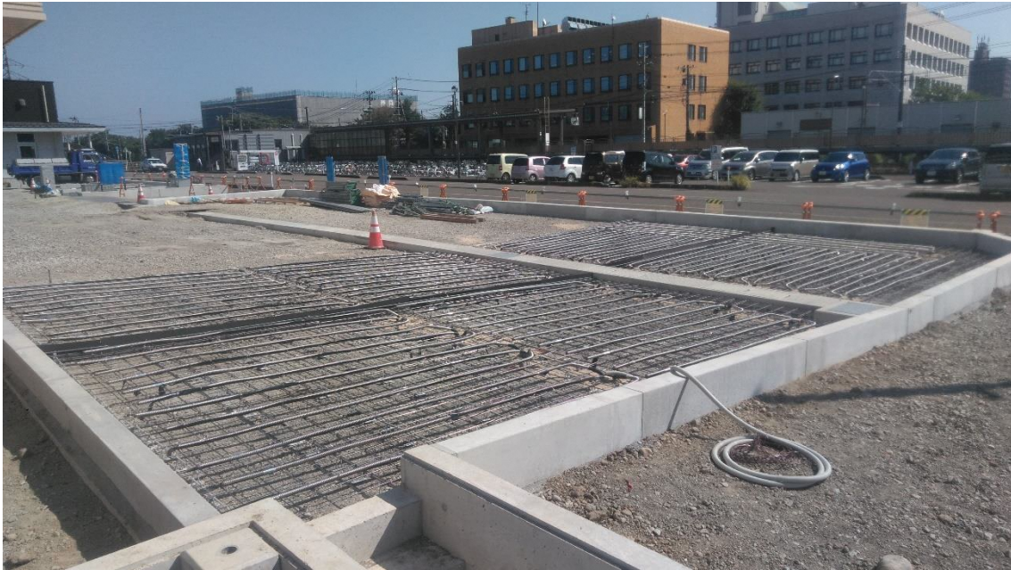
写真 3-3 ヒートパイプ敷設状況(東面)
