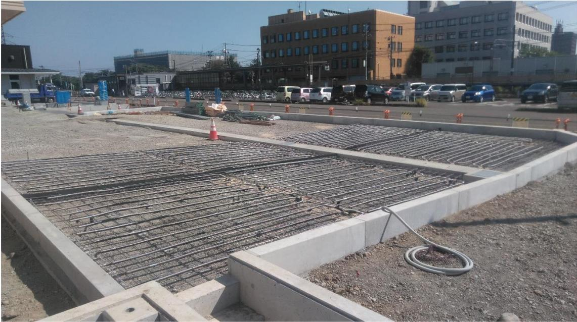
写真 3-3 ヒートパイプ敷設状況(東面)
