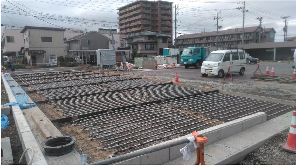
写真 3-1 ヒートパイプ敷設状況(西面)
