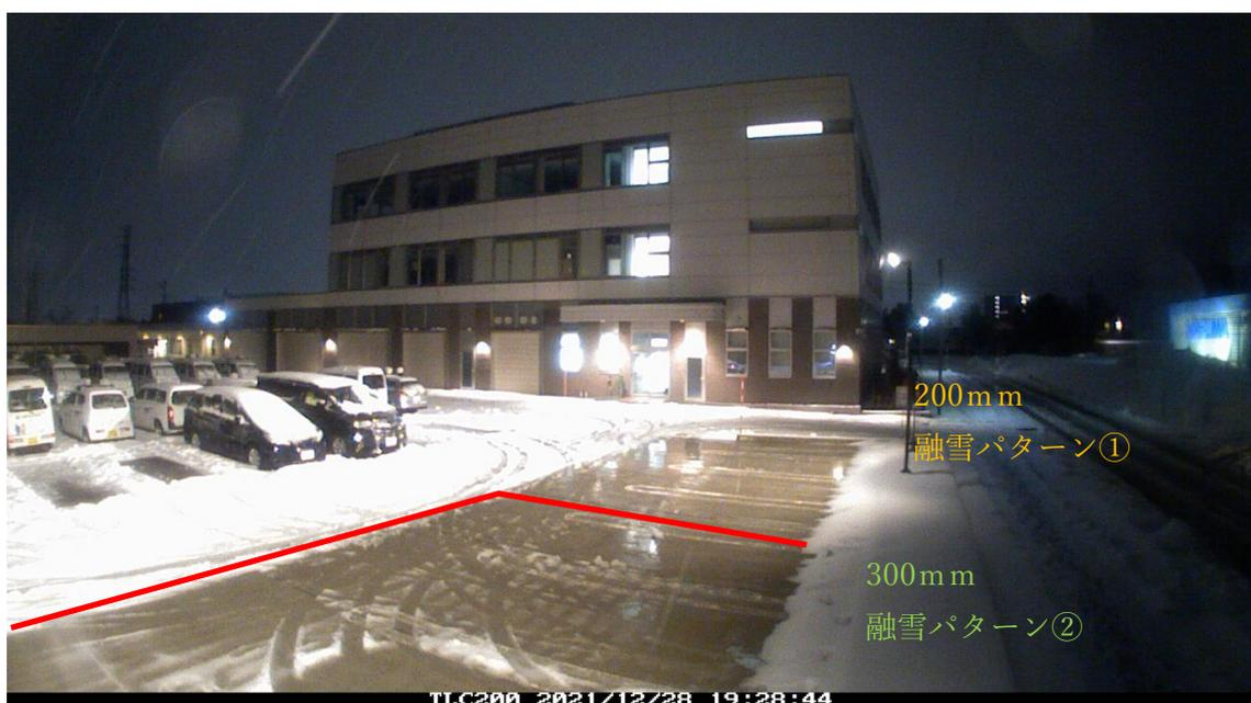
写真 5-1 堆雪場融雪状況 12 月 28 日 上：東面 下：西面
