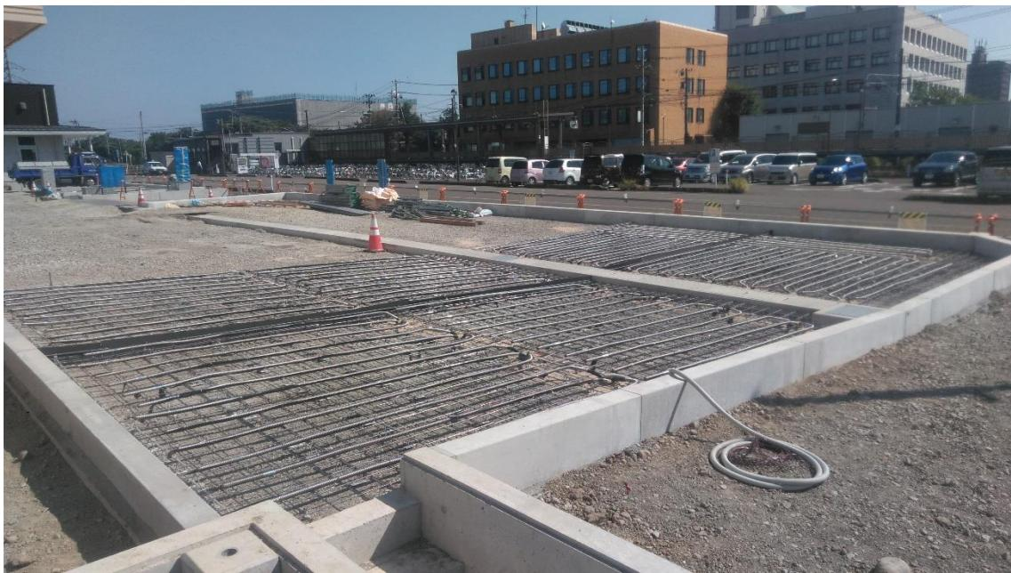
写真 3-3 ヒートパイプ敷設状況(東面)
