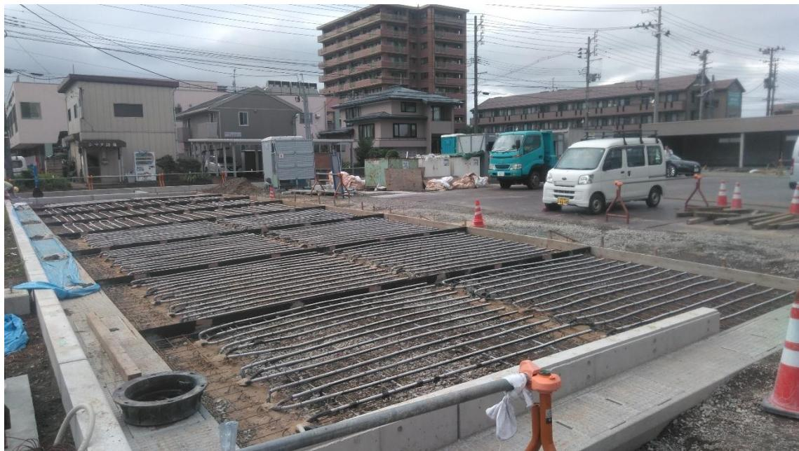
写真 3-1 ヒートパイプ敷設状況(西面)
