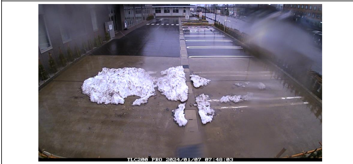
写真 5-3 東面堆雪場融雪状況 撮影箇所②
