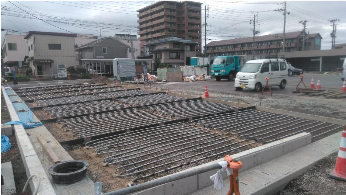
写真 3-1 ヒートパイプ敷設状況(西面)
