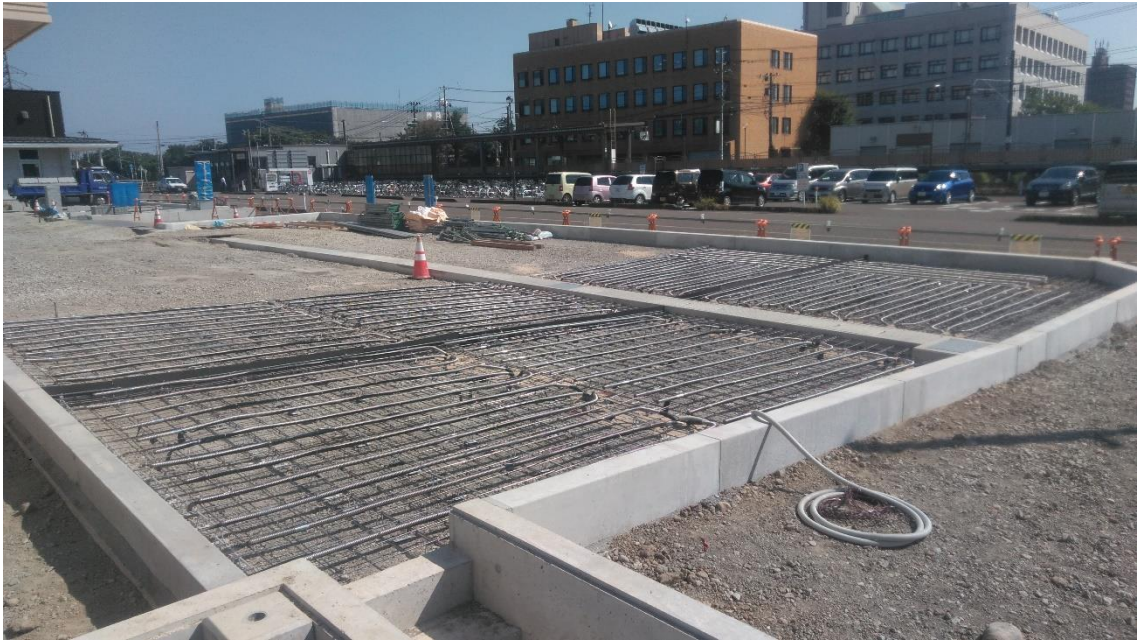
写真 3-3 ヒートパイプ敷設状況(東面)
