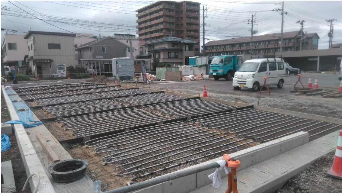
写真 3-1 ヒートパイプ敷設状況(西面)
