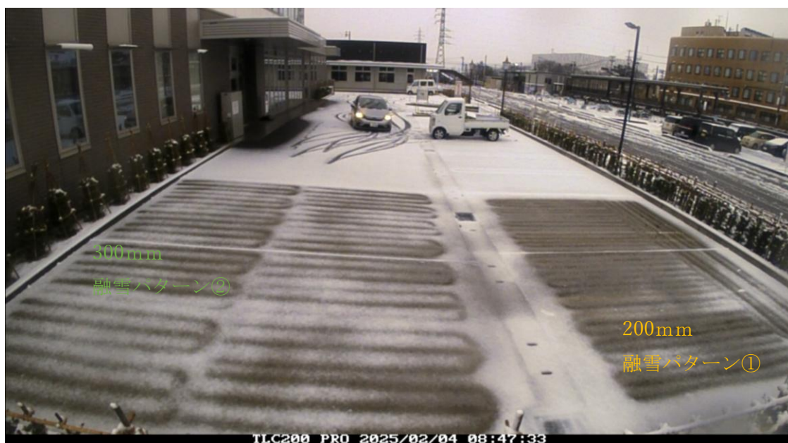
写真 5-1 東面堆雪場融雪状況 上：令和 7 年 1 月 9 日 21 時 下：令和 7 年 2 月 4 日 8 時
