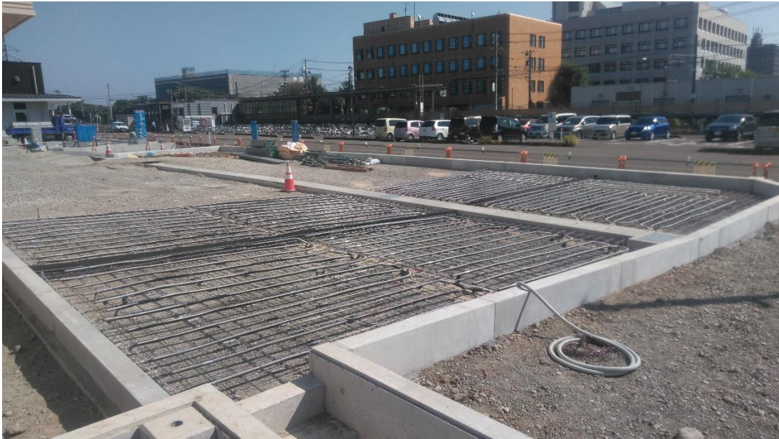
写真 3-3 ヒートパイプ敷設状況(東面)
