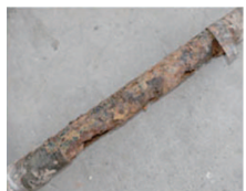
埋設約30年たった白ガス管
