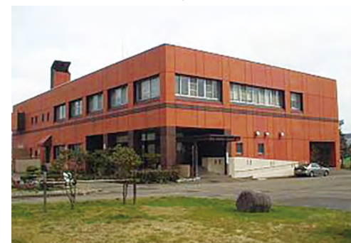
下水道センター
