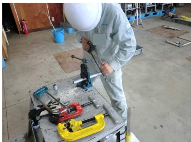
＜鋼管切断研修＞
