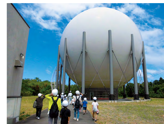
大湯ガス供給所
