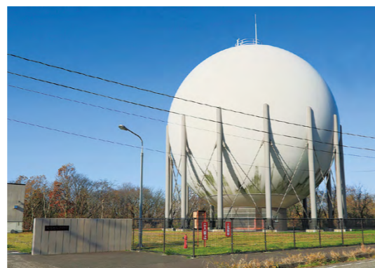
大潟ガス供給所
