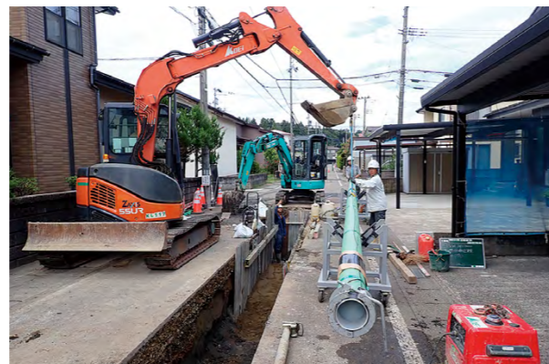
ガス管布設の様子
