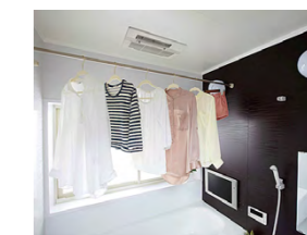
浴室暖房乾燥機
