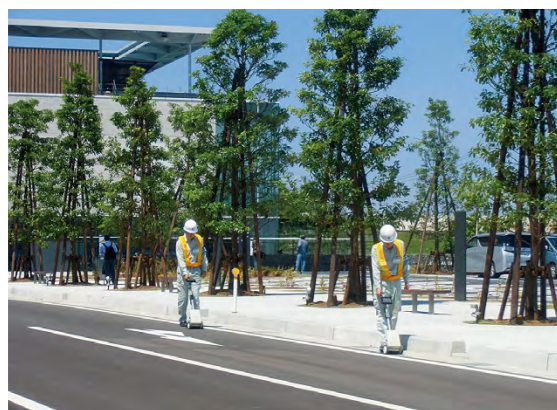
本支管ガス漏れ検査
