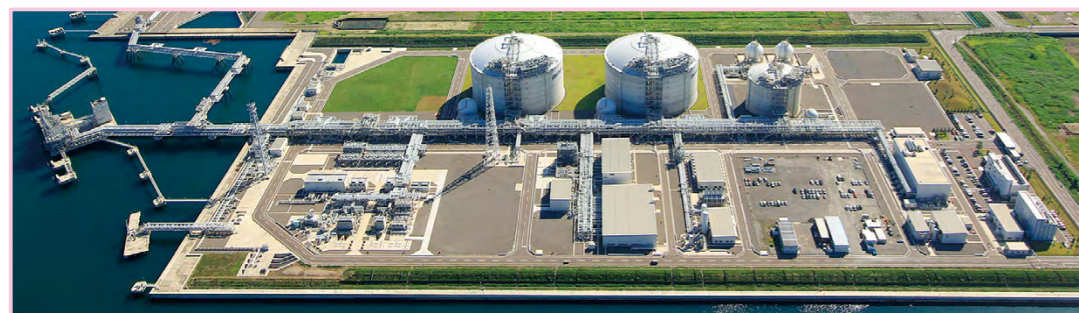
直江津LNG基地
