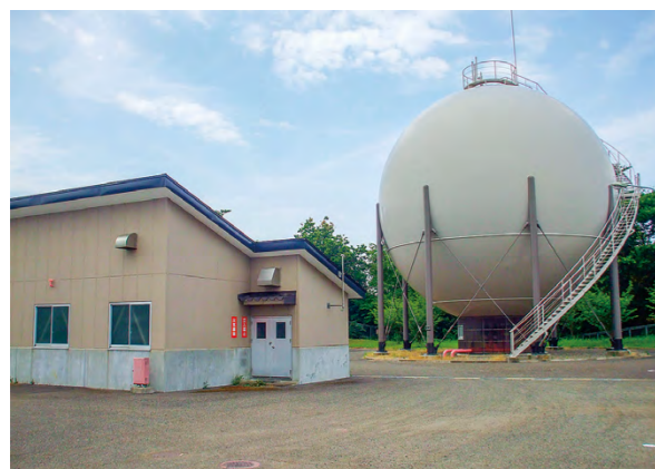
柿崎ガス供給所
