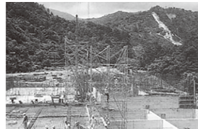
城山浄水場(昭和42年頃)
