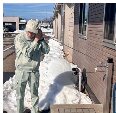
音聴棒による漏水調査
