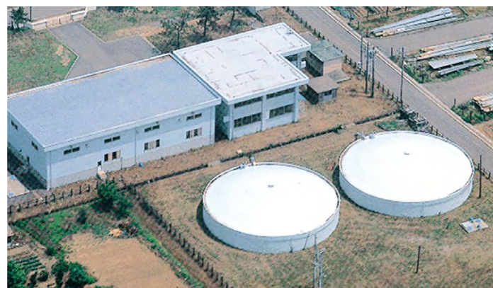
予備水源（深谷浄水場）
