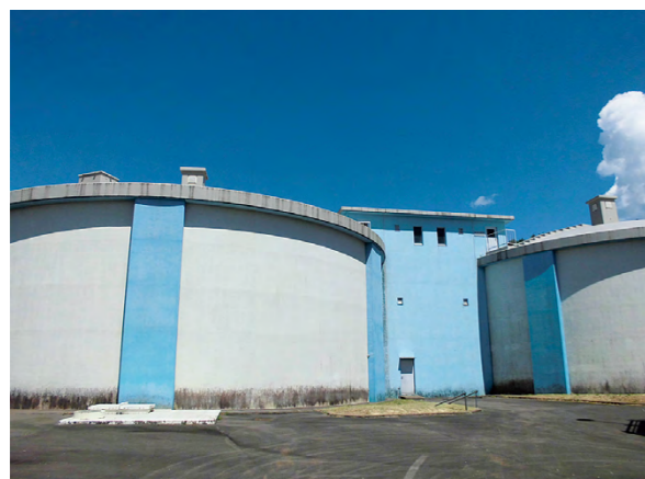
柿崎川浄水場 配水池
