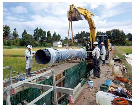
水道管布設の様子
