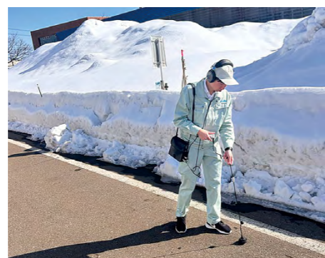
路面音聴漏水調査
