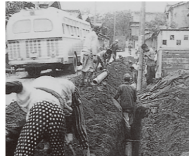
配水管布設工事(八千浦地区、昭和36年頃)
